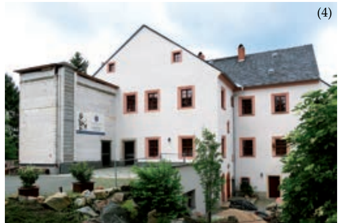
Der Lotterhof mit unverkleidetem Treppenhausanbau. (4)
